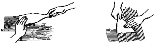
*Рис. 51. Разравнивание шпатлевки шпателем*
