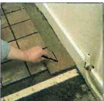
**4.** Уложить плитки в пристенном ряду. Если стена неровная, то каждую плитку надо подгонять отдельно, чтобы зазор между плиточным настилом и стеной был все время одинаковым.
