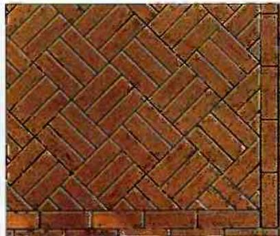
Диагональный насып "в шашечку" с двойным фризом. При такой укладке фриз упрощает образование зазора между насыпом и стеной.
