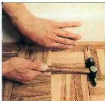
Плинтусы прибивают тонкими коваными гвоздями. В результате зазор между стеной и паркетом закрывается.
