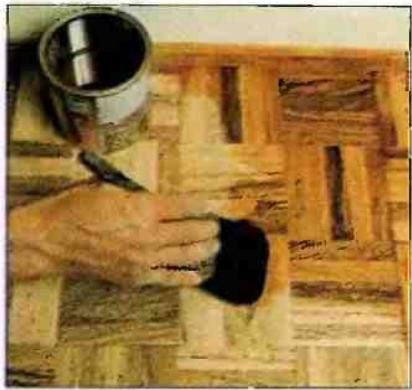
Стойкое лаковое покрытие получается, когда лак наносят на пол в три слоя. Прежде чем наносить очередной слой, дождитесь, когда высохнет предыдущий.
