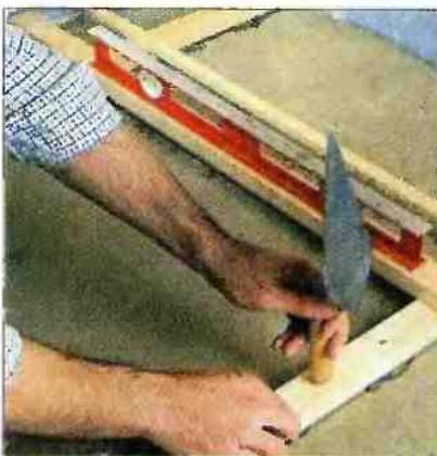
Рейки слегка прижимают. С помощью уровня и угольника проверяют, находятся ли они в нужной позиции по вертикали и горизонтали.
