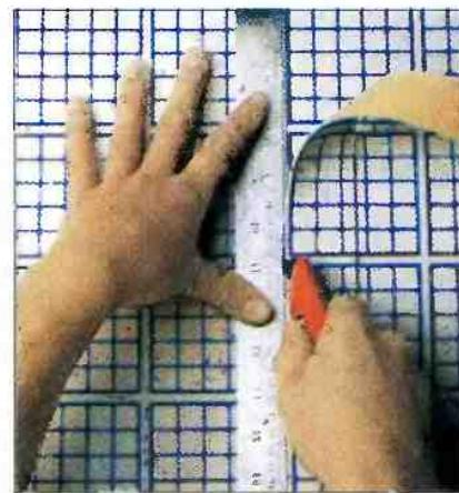
**5.** При стыковке двух полотен рисунок должен совпадать. Для этого оба полотна укладывают внахлест и одновременно разрезают.
