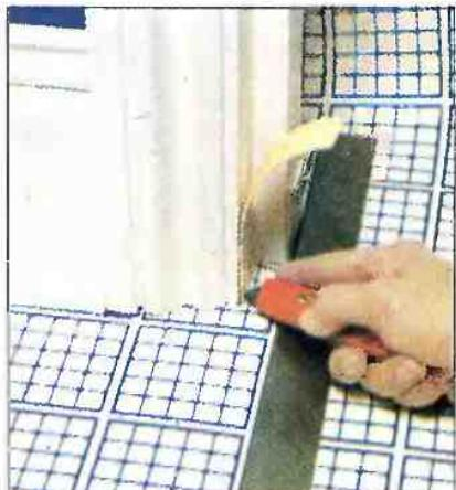
**3.** Загнутый край полотна удверного проема надрезают несколько раз для подгонки под проем. Движения должны быть предельно точными – особенно при сложной конфигурации проема.
