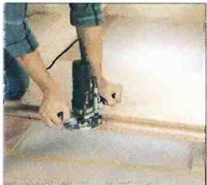
*Настилом служат древесно-стружечные плиты. Если у вас есть фрезерное устройство, вы сами сможете обработать кромки плит для соединения их вставными продольными шипами.*
