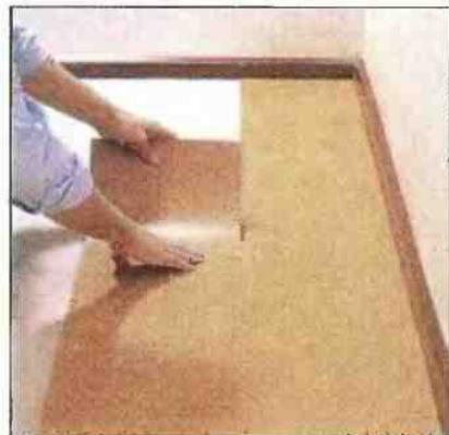
Пробка считается идеальным покрытием – она теплая на ощупь, приятно пружинит и дышит. Пробковые плиты легко укладывать.
