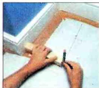
С помощью короткой рейки и укрепленного на ней фломастера очерчиваются контуры стен. Так получается шаблон.
