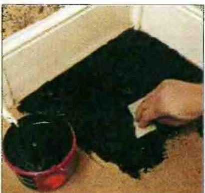
Клей следует наносить под паркетный щит не спеша, очень аккуратно и в соответствии с инструкцией изготовителя.
