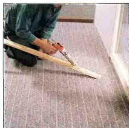
Плинтус окантовывает пол и одновременно зажимает ковровое покрытие. Плинтус закрепляют монтажным клеем.
