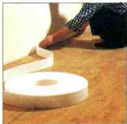
По периметру помещения вдоль стен укладывают узкую пенопластовую полоску для образования температурных швов между заливкой и стенами.
