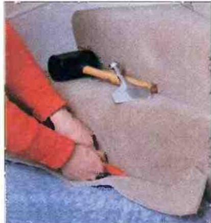
Если лестница винтовая, то ковер укладывают отрезками, каждый из которых рассчитан на одну ступень.
