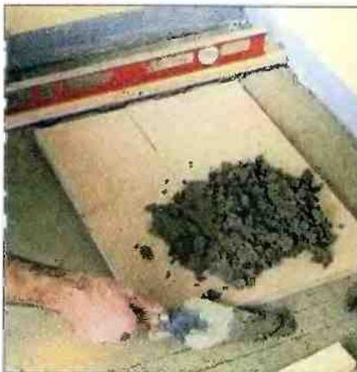
На основании пола размечают расположение реек, которые затем укладывают на комочки бетона — для выравнивания.
