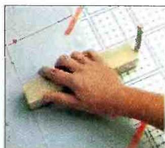
С готового шаблона контуры стен переносят на ПВХ-покрытие.
