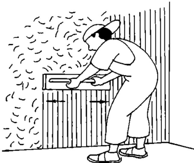
Рис. 10. Разравнивание раствора на стене полутерком
