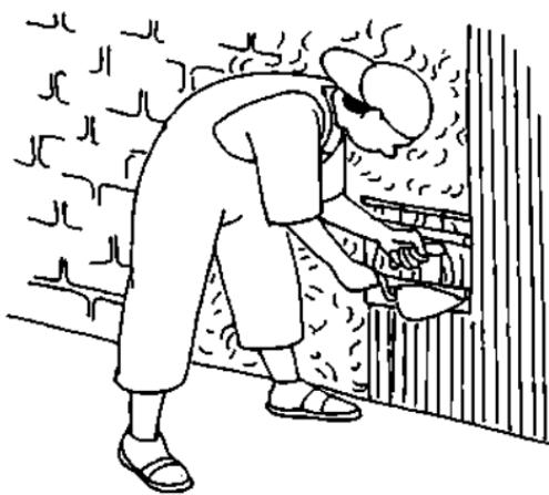
Рис. 9. Намазывание раствора на стены с сокола
