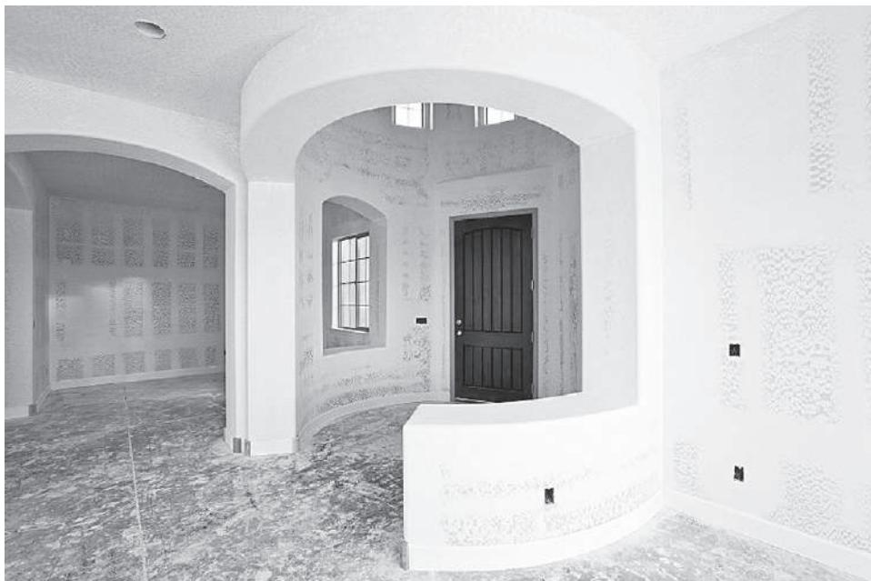
Рис. 8.21. Криволинейная неполная перегородка
