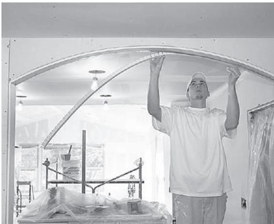
Рис. 8.2. Монтаж арки
