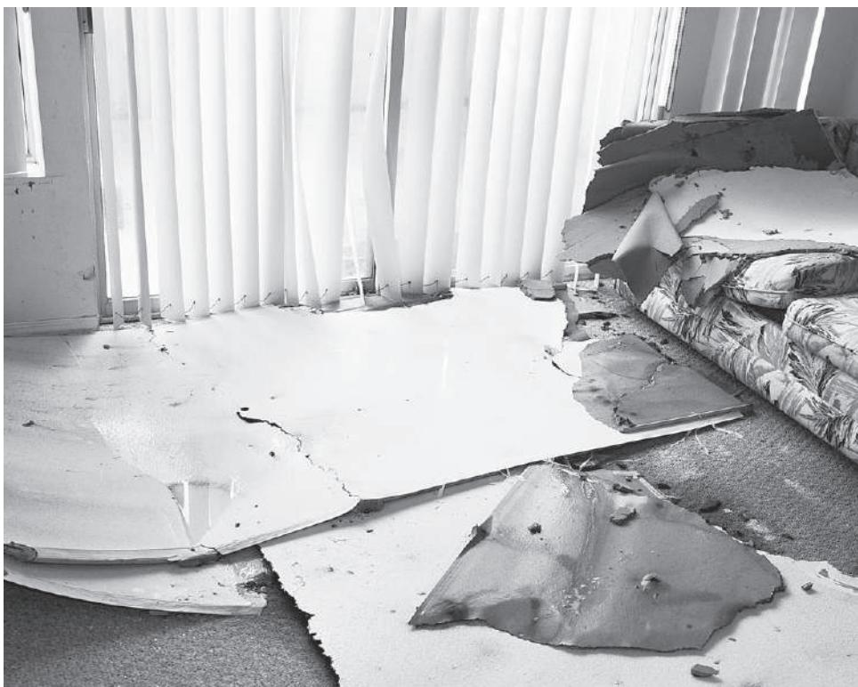
**Рис. 10.7.** Наибольшую угрозу гипсокартонным конструкциям представляет вода
