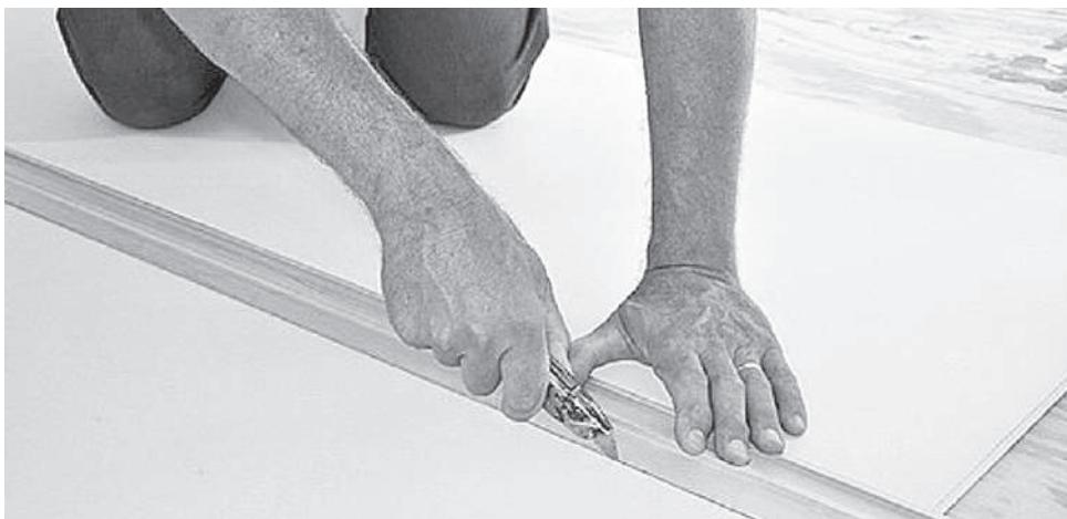
**Рис. 4.9.** Резка гипсокартона
