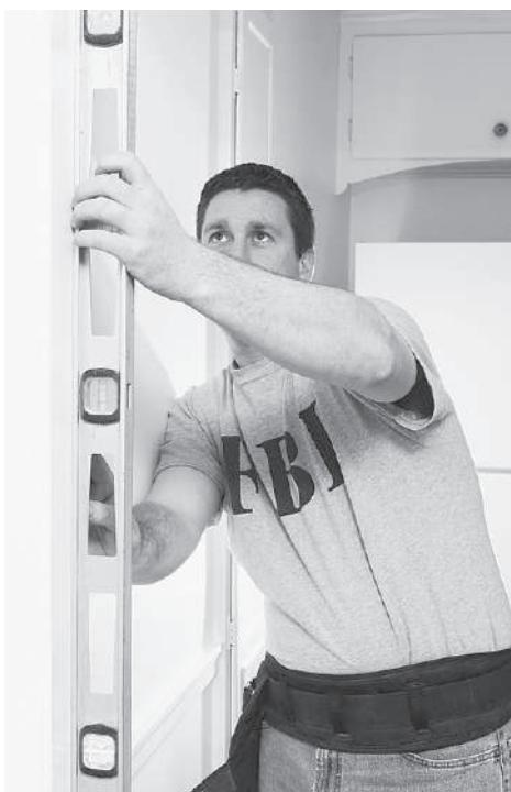
Рис. 3.17. Измерение вертикали стены при помощи уровня
