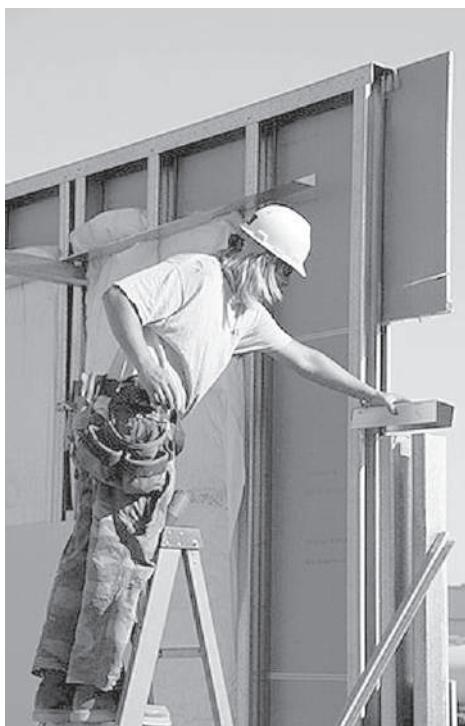
**Рис. 4.38.** Монтаж гипсокартонной
