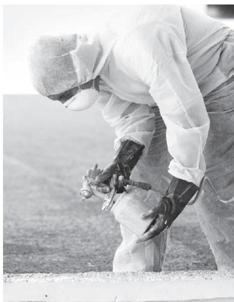
**Рис. 9.33.** Окраска при помощи распылителя
