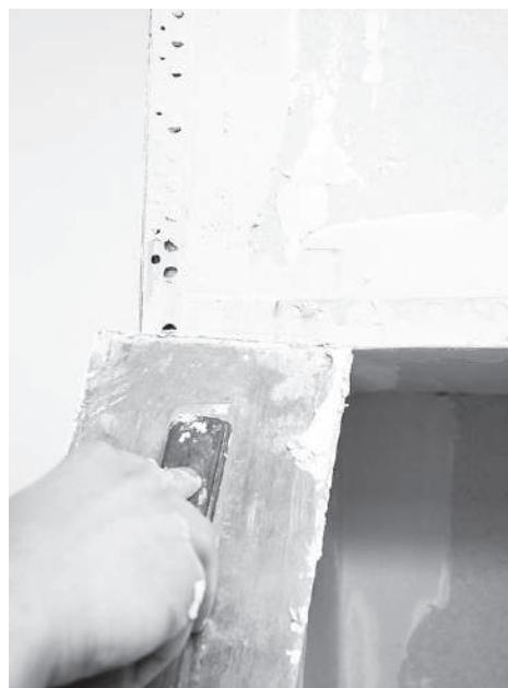
Рис. 9.24. Шпаклевка углов
