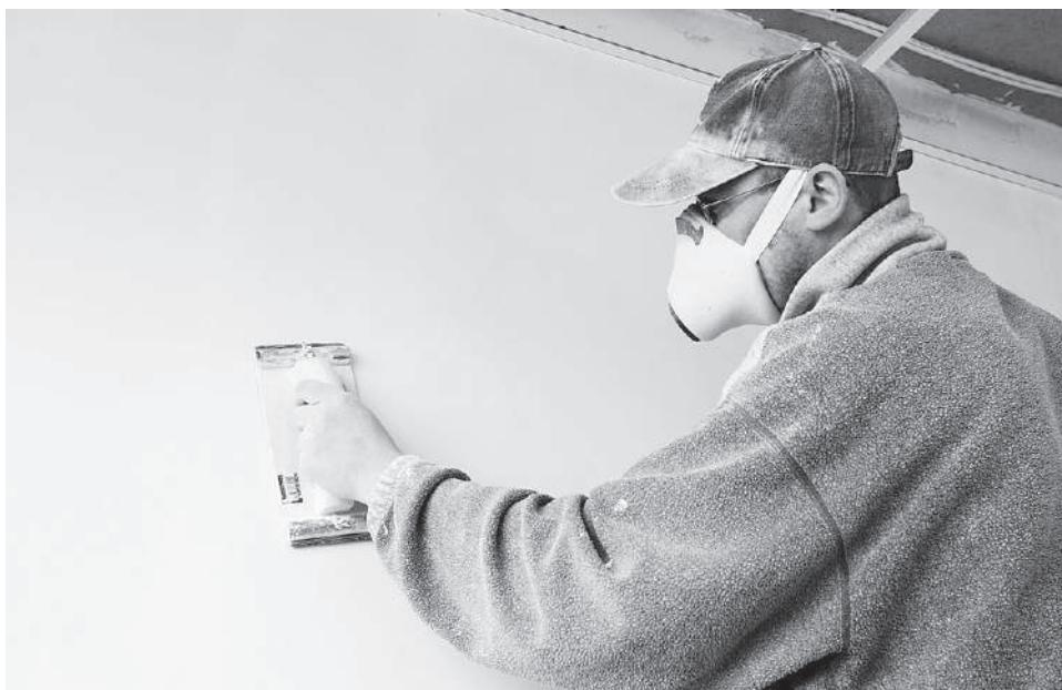
Рис. 9.25. Зашкуривание шпатлевки
