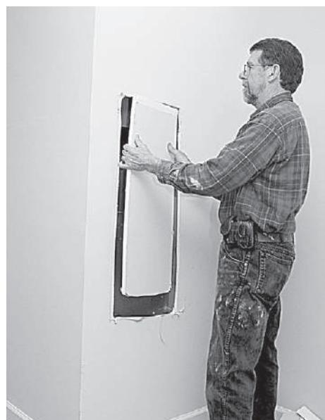
Рис. 8.12. Выпиленный кусок вынимается из стены
