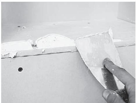
**Рис. 9.20.** Для заделки углов и сложных поверхностей удобнее использовать небольшой шпатель
