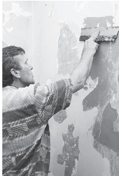
**Рис. 4.5.** Выравнивание стены штукатуркой
