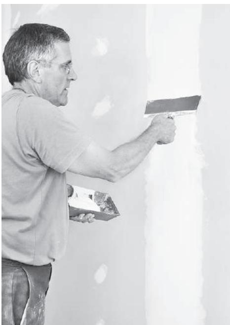
Рис. 9.14. Заделка швов
