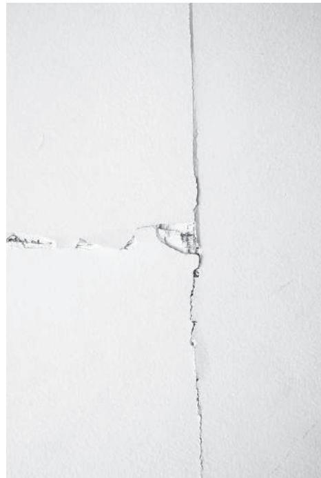
Рис. 10.2. Трещины на гипсокартоне
