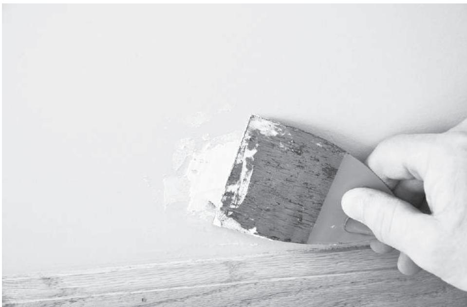
**Рис. 10.3.** Замазывание дефекта шпателем
