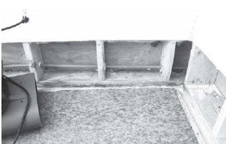
**Рис. 4.34.** Обшивка деревянного каркаса листом
