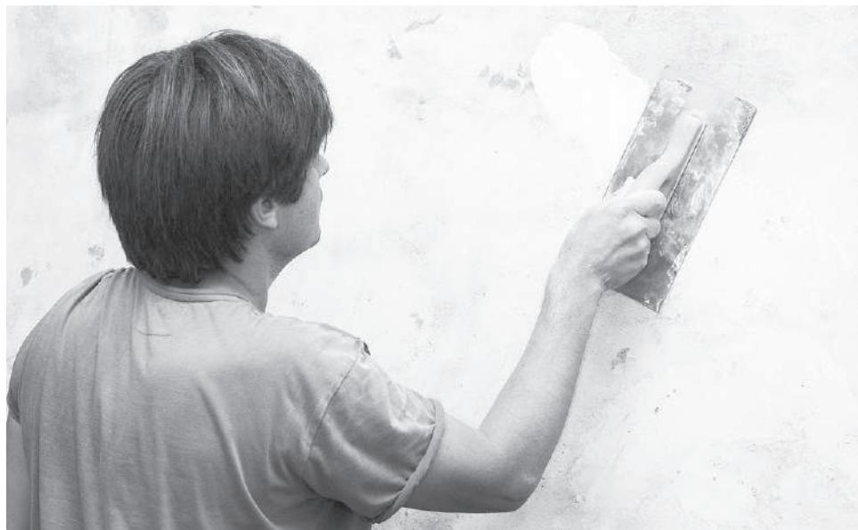
**Рис. 4.4.** Финальное выравнивание стены
