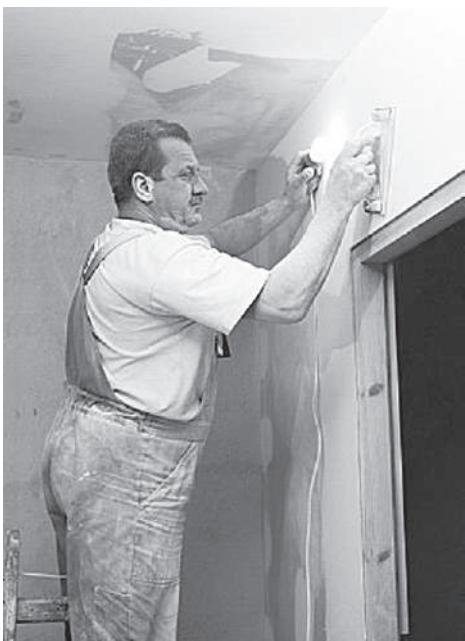
**Рис. 9.28.** Зашкуривание поверхности с лампой
