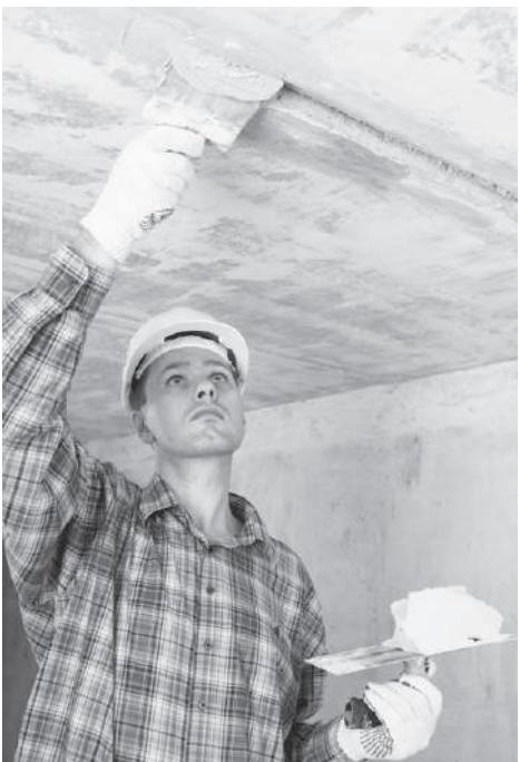
**Рис. 6.2.** Заделка щелей между потолочными плитами смесью
