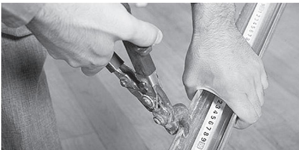
**Рис. 3.8.** Обрезка профиля при помощи ножниц по металлу
