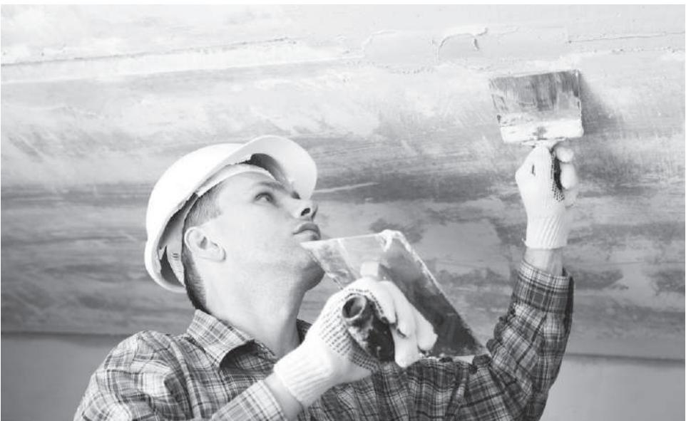
**Рис. 6.3.** Выравнивание смеси при помощи шпателя
