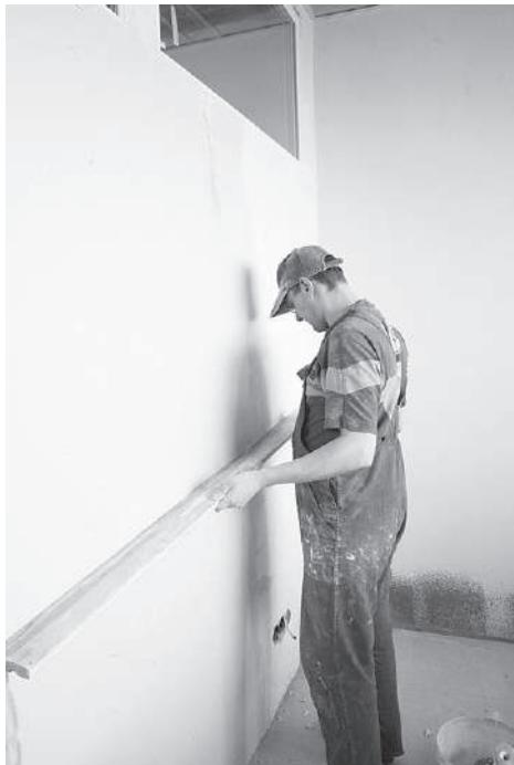
Рис. 3.12. Проверка плоскости стены правилом
