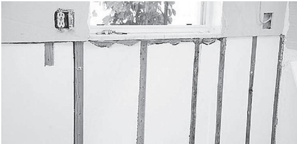
**Рис. 4.26.** Деревянный каркас с плитами пенопласта
