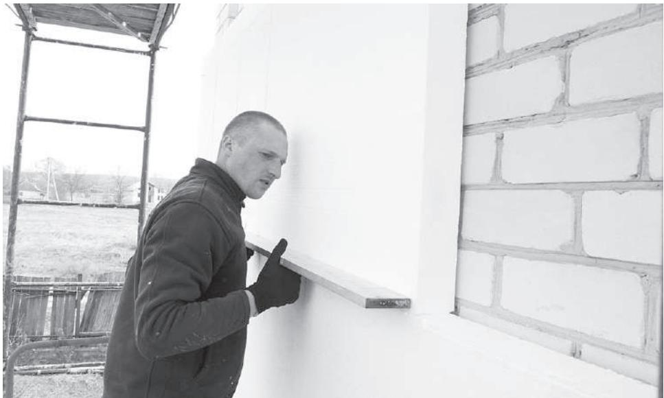
Рис. 2.23. Утепление поверхности плитами пенопласта
