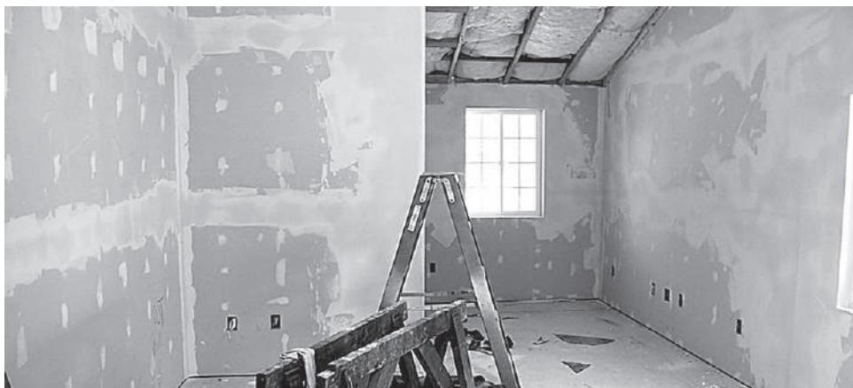
Рис. 4.30. Готовая облицовка стен с потолочным каркасом
