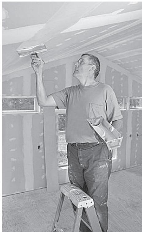
**Рис. 9.15.** Заделка потолочных швов
