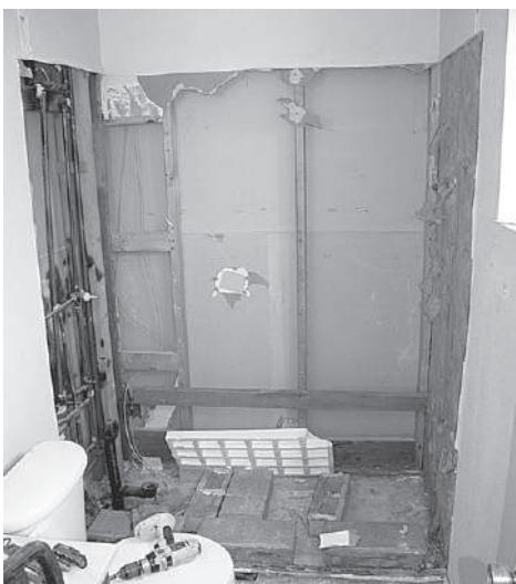
Рис. 4.24. Деревянный каркас
