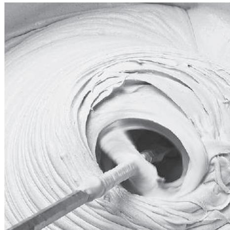
**Рис. 9.18.** Замешивание шпатлевки при помощи миксера
