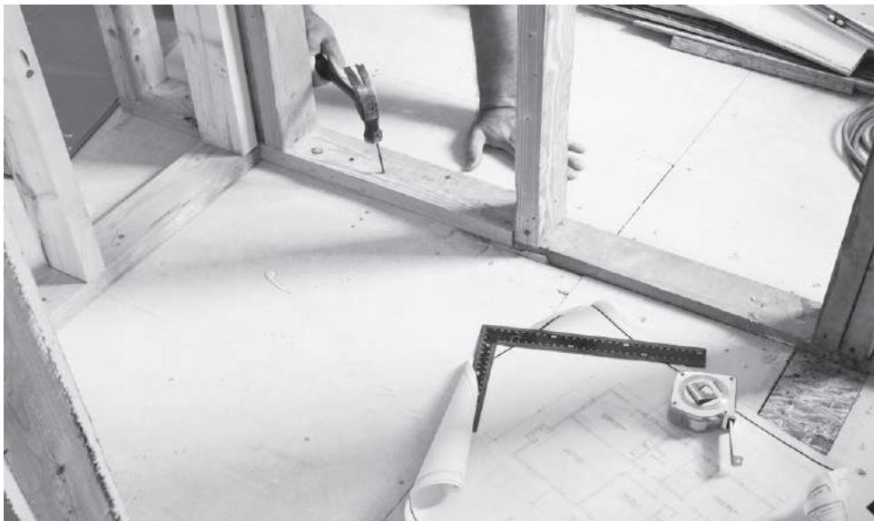
**Рис. 5.3.** Крепление бруска обвязки
