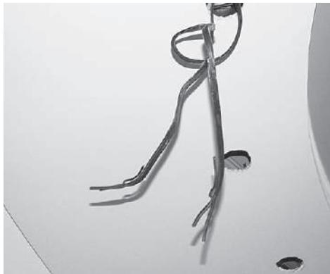
**Рис. 9.3.** Потолок с вырезанными отверстиями под светильники
