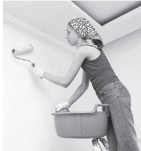
Рис. 6.4. Грунтование поверхности при помощи валика
