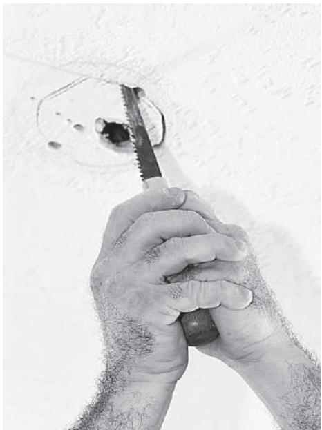
**Рис. 9.11.** Выпиливание отверстия под светильник в гипсокартонном потолке
