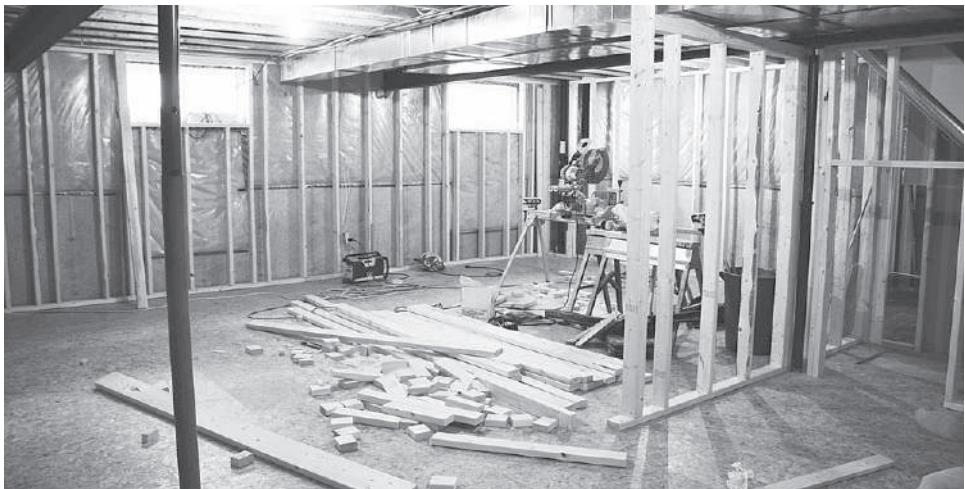
Рис. 4.23. Облицовочный и перегородочный деревянные каркасы
