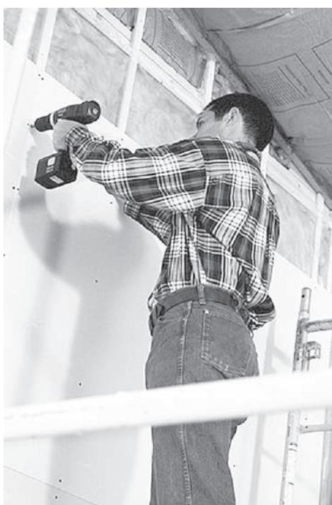
**Рис. 4.35.** Крепление листов гипсокартона к деревянному каркасу
