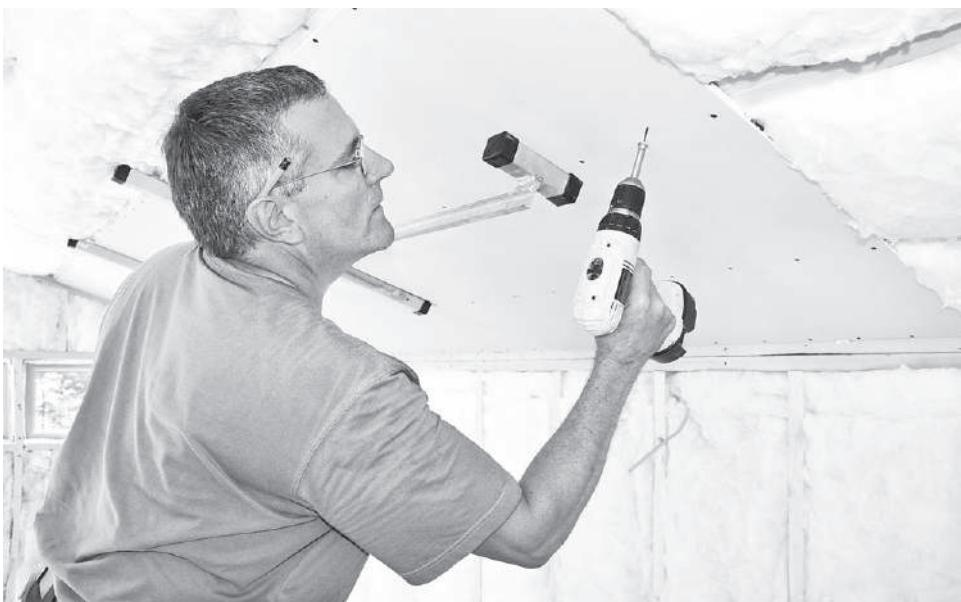
Рис. 6.5. Обшивка потолочного каркаса гипсокартоном
