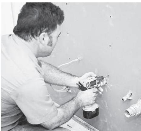
**Рис. 4.32.** Закручивание шурупов при помощи аккумуляторной дрели
