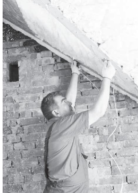
**Рис. 6.9.** Монтаж утеплителя
