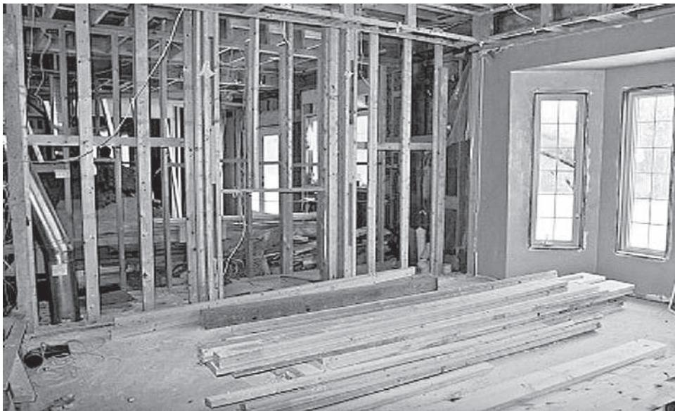
**Рис. 5.4.** Вариант перегородки на деревянном каркасе
