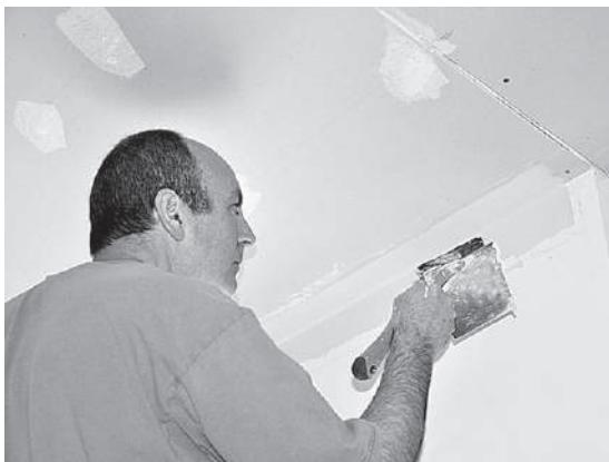
**Рис. 9.16.** Заделывание внутреннего угла
