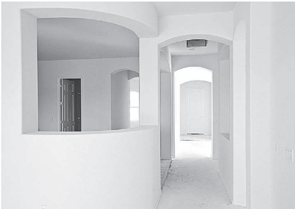
**Рис. 8.22.** Вариант неполной перегородки
