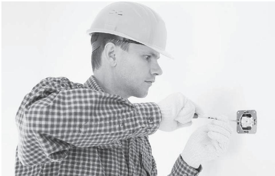
**Рис. 9.10.** Закрепление колодки на гипсокартоне
