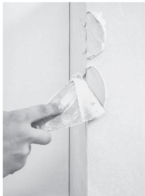
**Рис. 4.3.** Заделывание угловой трещины штукатуркой
