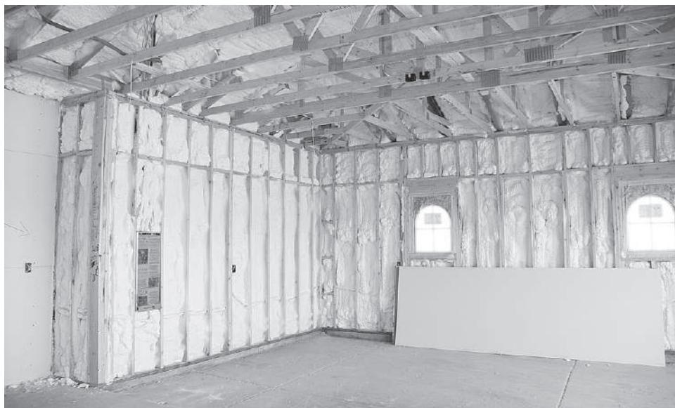
Рис. 4.17. Готовый деревянный облицовочный каркас
