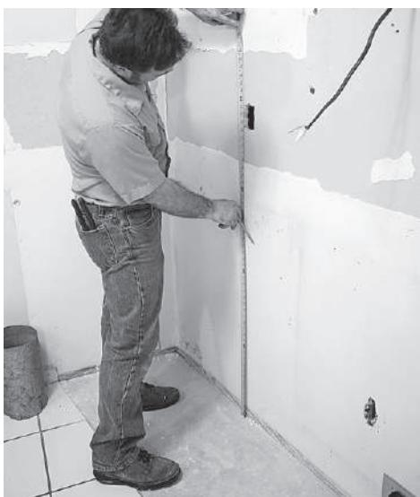
**Рис. 9.4.** Замер электрической точки
