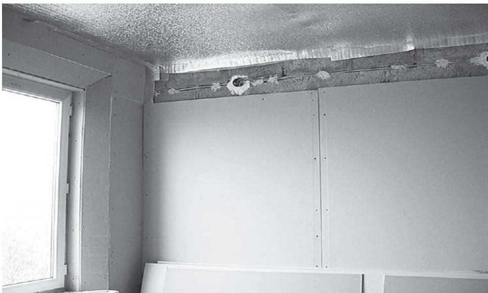
**Рис. 6.12.** Потолок, покрытый термоизоляционной пленкой
