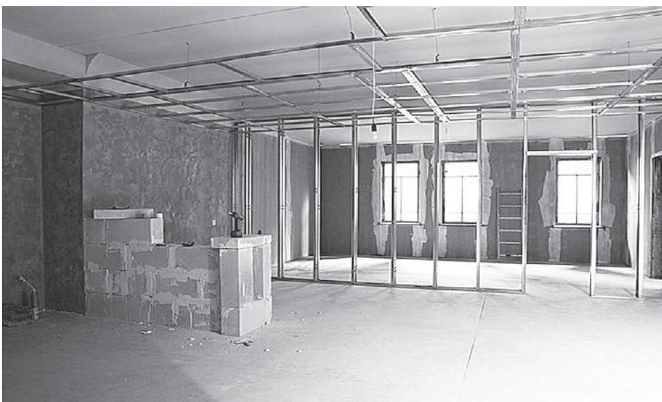
**Рис. 5.5.** Металлический каркас потолка и перегородки
