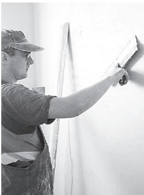
Рис. 9.23. Шпаклевание гипсокартона
