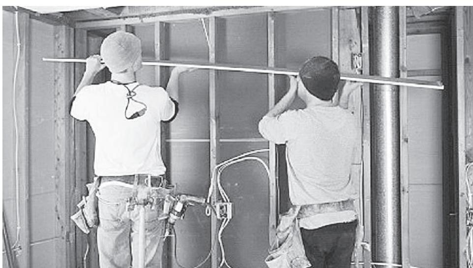
Рис. 4.18. Монтаж перегородки на деревянном каркасе
