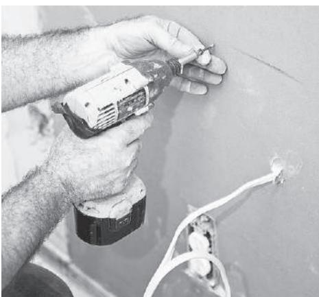
**Рис. 4.33.** Положение рук при закручивании крепежа
